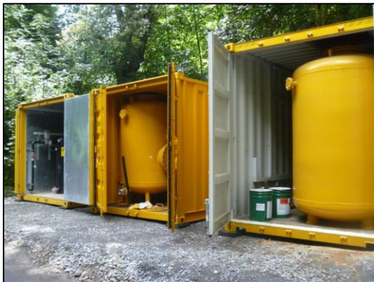
Abb.4: Reinigungsanlage am Ostbach
