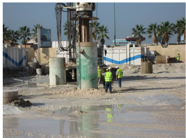
Abbildung 13 Einbringen der Verrohrung
