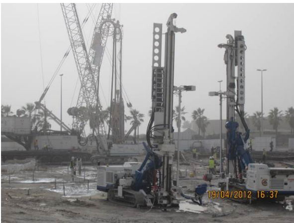
Abbildung 19 Bohrgeräte für Injektionsbohrungen
