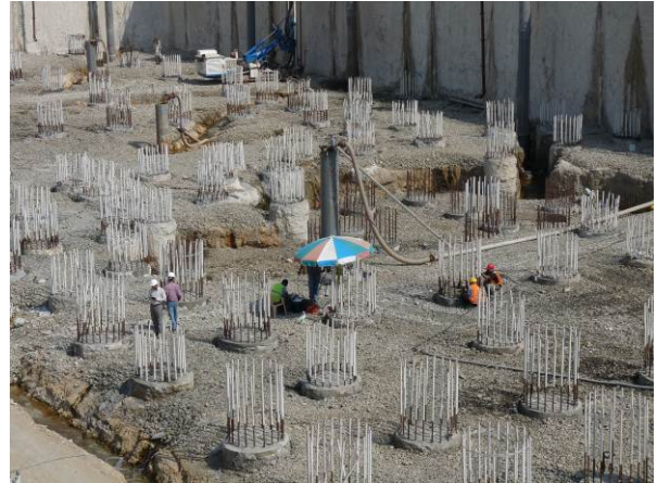
Abbildung 16 Bohrpfähle im Hochhausbereich
