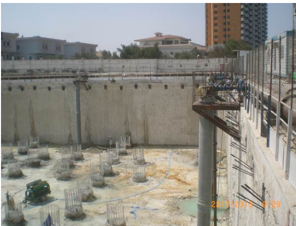
Abbildung 23 Wasserhaltung im Betrieb
