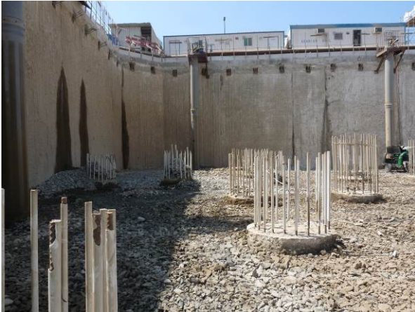
Abbildung 18 Schlitzwand während des Aushubes
