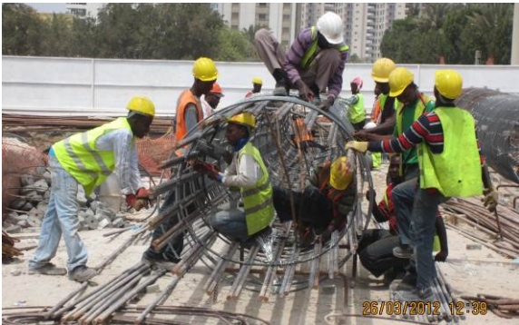
Abbildung 14 Herstellen der Bewehrungskörbe
