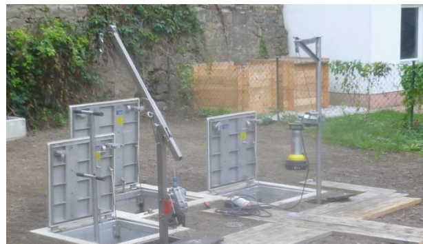
Abbildung 6-11 - Schachteinstieg und Wartungsöffnung mit Sicherheitssteigleiter, Wartungskran und Lenzpumpe
