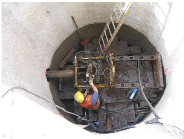
Abbildung 6-6 - Schachtbauwerk als Startbaugrube für Rohrvortrieb
