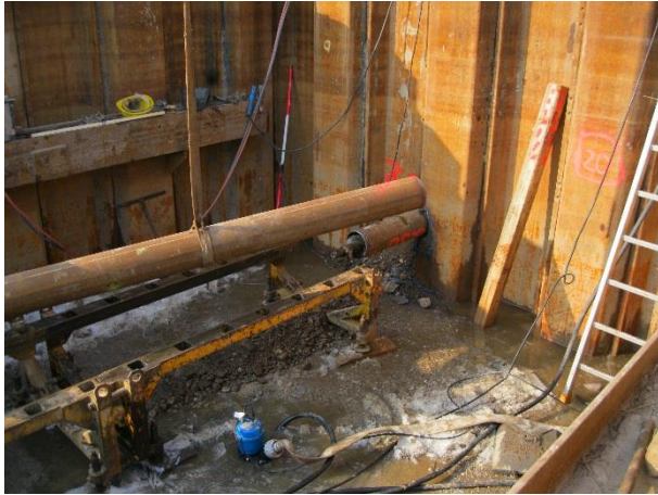
Abbildung 6-8 - Spundwandbaugrube am Auslaufbauwerk
