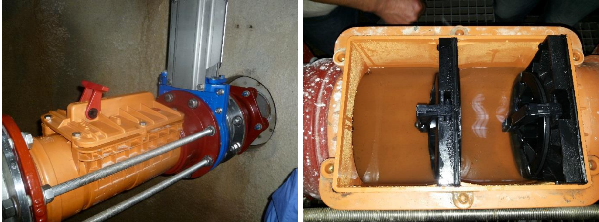
Abbildung 6-5 - KESSEL-Rückstaudoppelschloss Staufix© und Absperrschieber VAG Zeta 300
