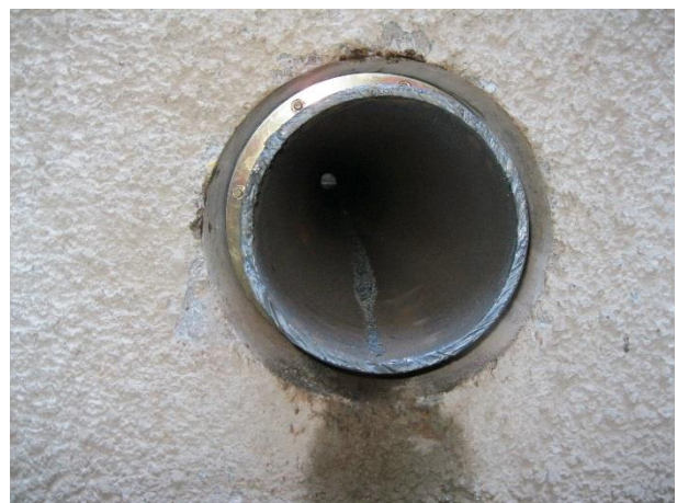
Abbildung 6-7 - Abdichtung der Durchdringungsstelle mit Gliederkettendichtung
