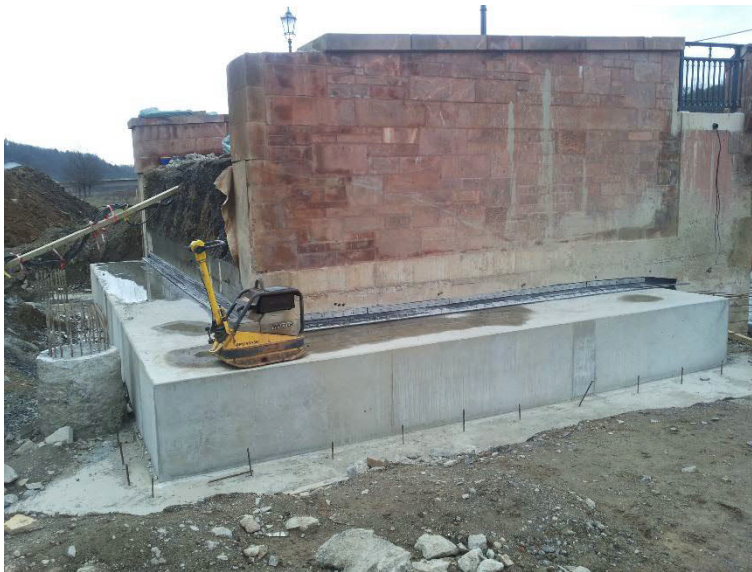
Abbildung 6-15 – fertig gestellter Kopfbalken
