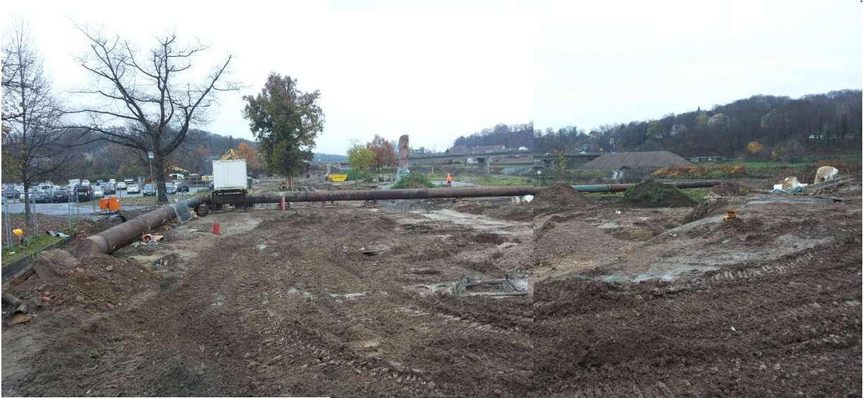
Abbildung 6-23 - Heberleitung zur bauzeitlichen Umflut des Thostgrundbachs
