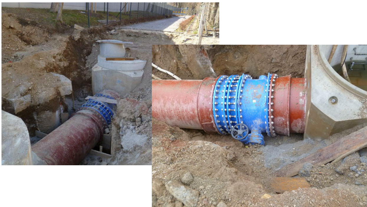
Abbildung 6-21 - Durchdringung DN 1200
