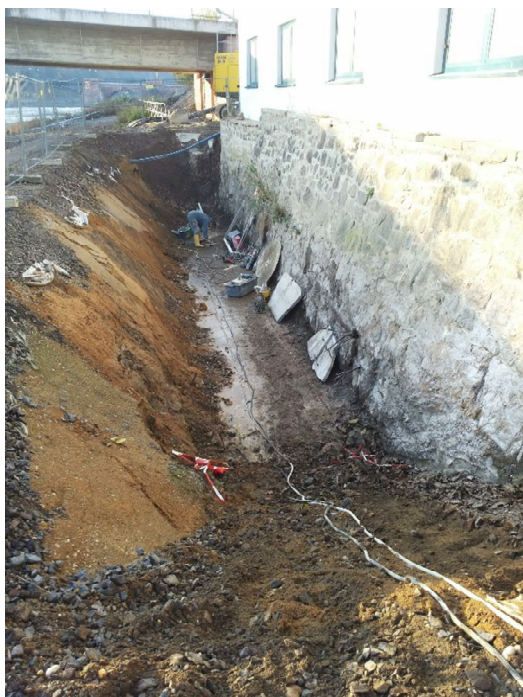
Abbildung 6-8 - Hindernis Betonplatte
