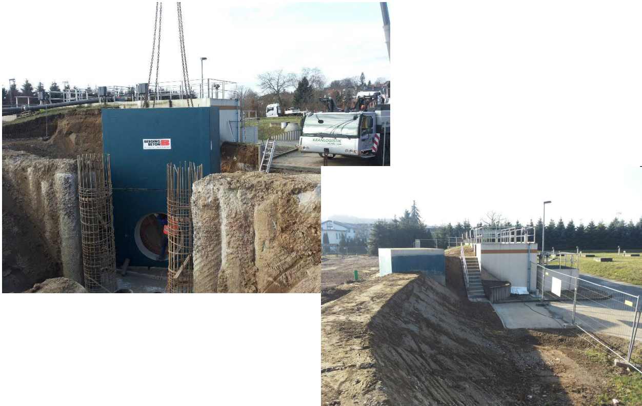
Abbildung 6-22 - Einbau des landseitigen Schachts für Leitungsquerung DN1800/DN1600
