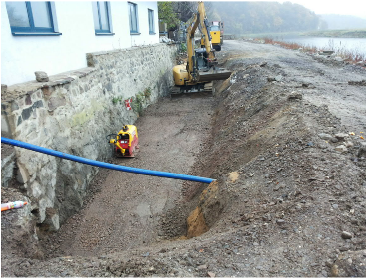
Abbildung 6-9 - Situation nach Hindernisbeseitigung
