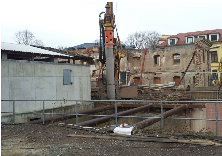
Abbildung 6-1 - Bohrarbeiten am Kraftwerkskanal
