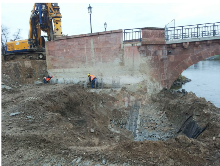
Abbildung 6-12 - Pfahlherstellung am Brückenwiderlager
