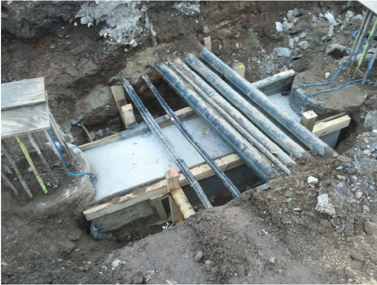
Abbildung 6-25 - für Eindichtung vorbereitetes Glasfaserpaket
